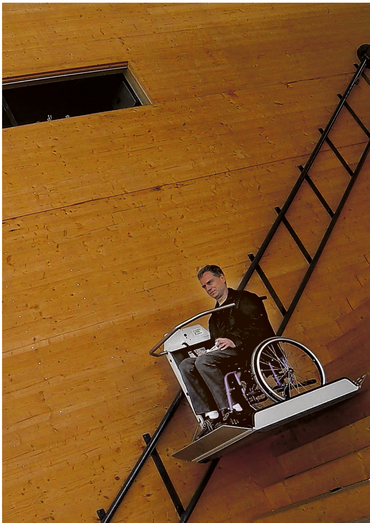
Altersgerecht bauen heisst menschengerecht bauen: Treppenlifte, breite Türen und hindernisfreie Durchgänge ermöglichen die Selbständigkeit im Alter.
